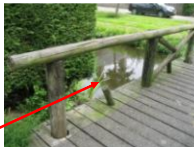
Figuur 4.2: Een reële kans op risicoaansprakelijkheid. Hier is direct herstel – klein onderhoud – vereist.
